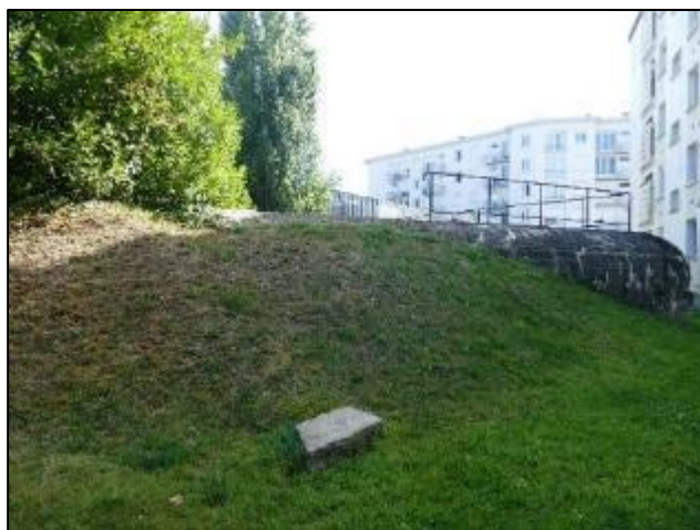
Entrée du blockhaus bouchée
