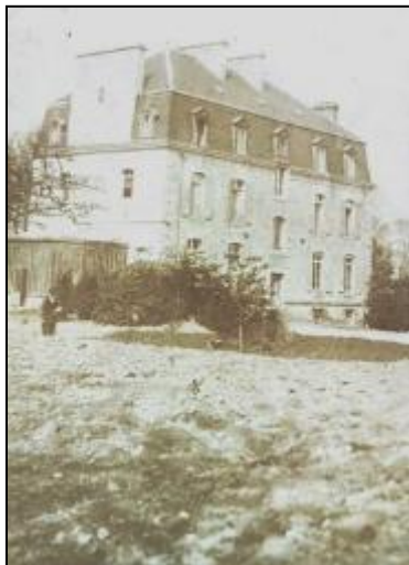
Façade arrière de la villa, donnant sur le parc.
