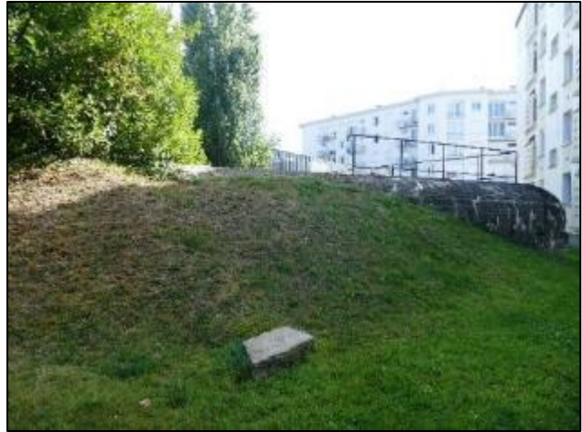
Entrée du blockhaus bouchée
