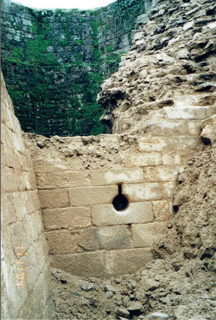
Bouche à feu extérieure
